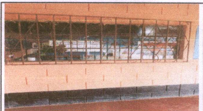
Foto 4: Pintada de las paredes de la Escuela
